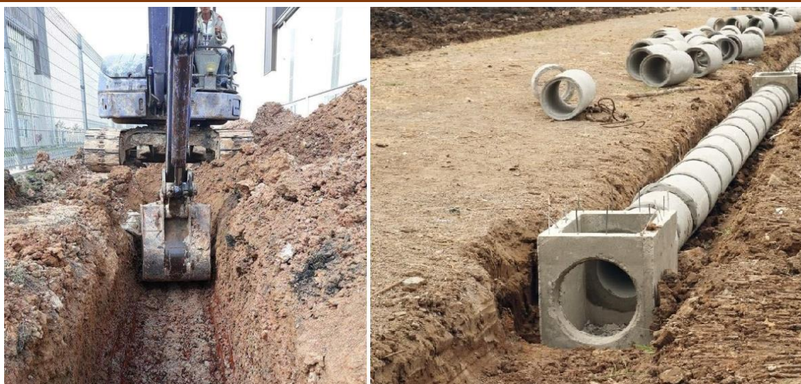
Hình 3. 1 Hoạt động thi công hệ thống thoát nước
