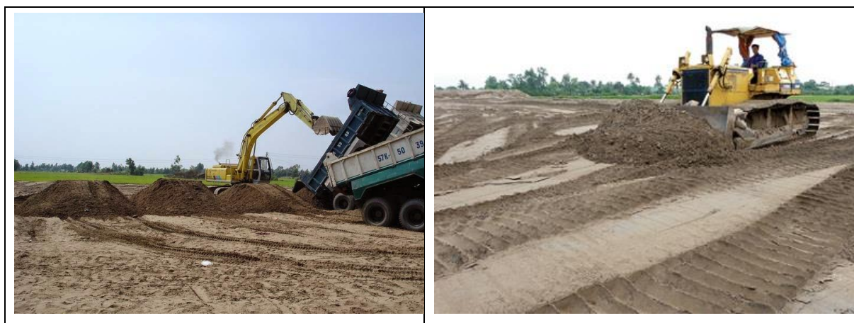
Hình 3. 3 Hình ảnh quá trình đào, đắp san gạt mặt bằng (minh họa)
