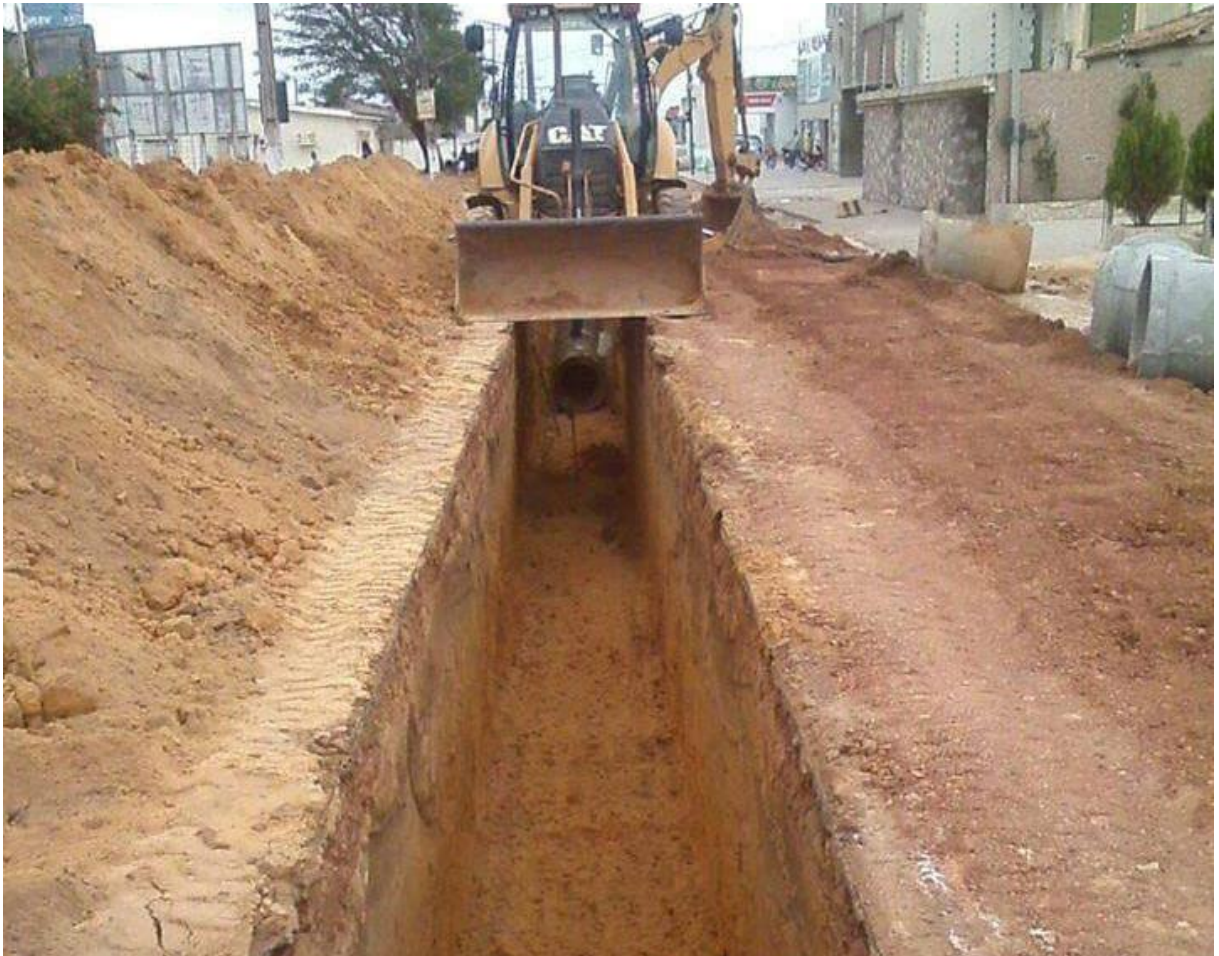
Hình 3. 5. Hoạt động thi công hệ thống thoát nước (minh họa)
