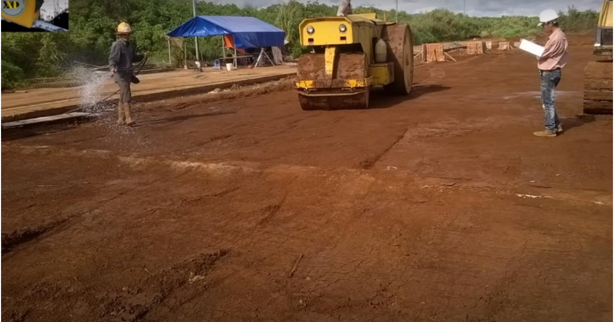
Hình 3. 2. Tưới ẩm đất trong quá trình san nền
